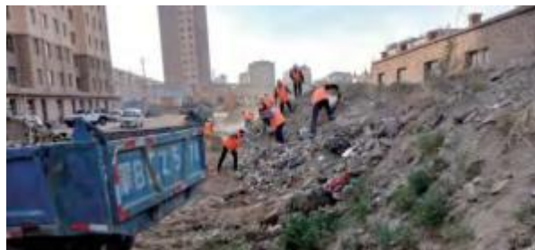
生活垃圾清运现场
