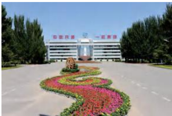
一机集团公司办公大楼
