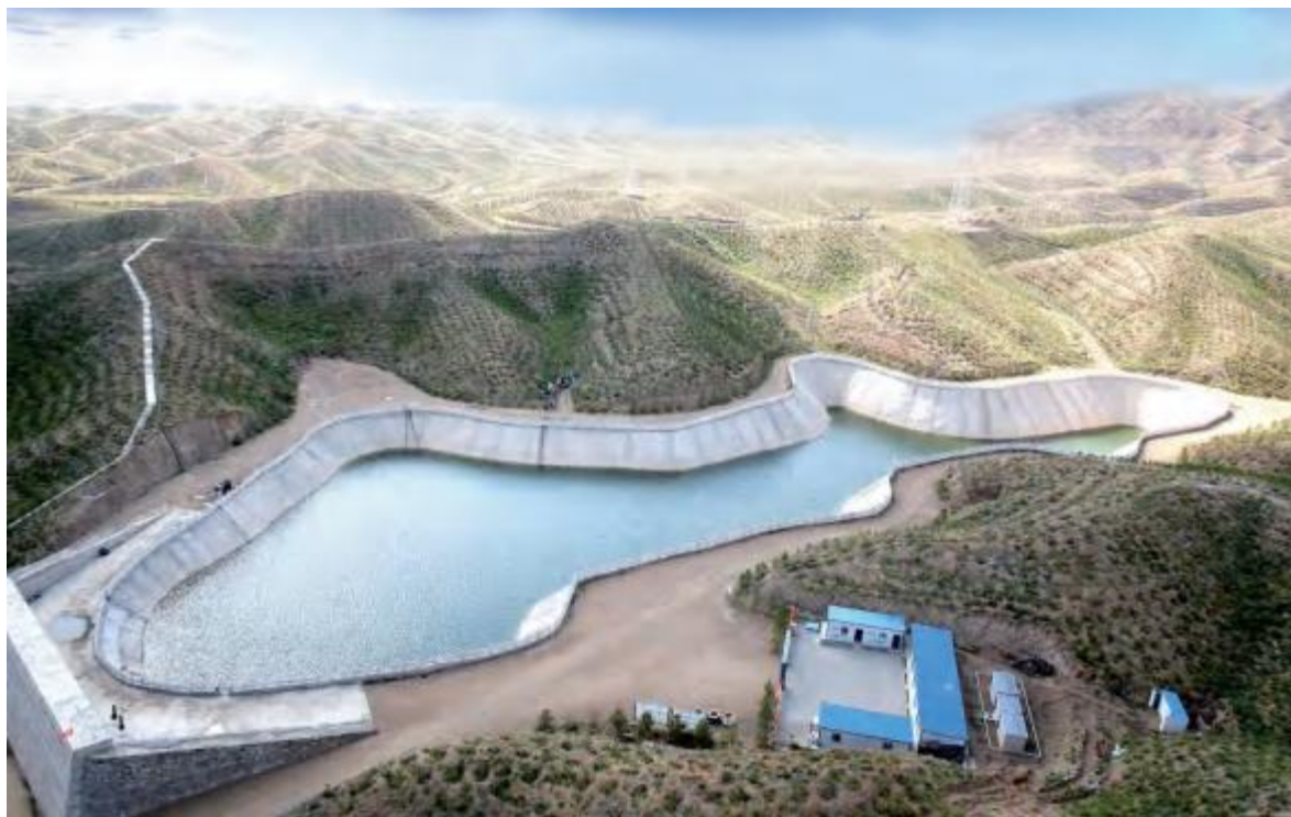
大青山南坡生态建设绿化灌溉蓄水池
