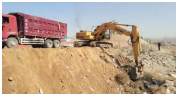
河道垃圾清理现场
