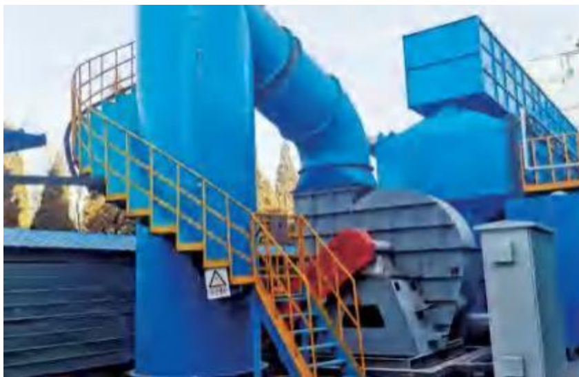
图 48 2022 年 6 月，一机集团三分公司开展焊接烟尘和 VOCs 治理项目设备调试 (一机集团 供图)
