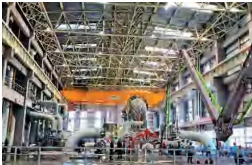
图 55 2022 年，内蒙古电建一公司到鄂尔多斯市鄂托克前旗上海庙能源化工基地实施北方联合电力长城电厂 2 \times 1000 兆瓦机组工程 EPC 总承包项目重大工程 (内蒙古电建一公司 供图)
