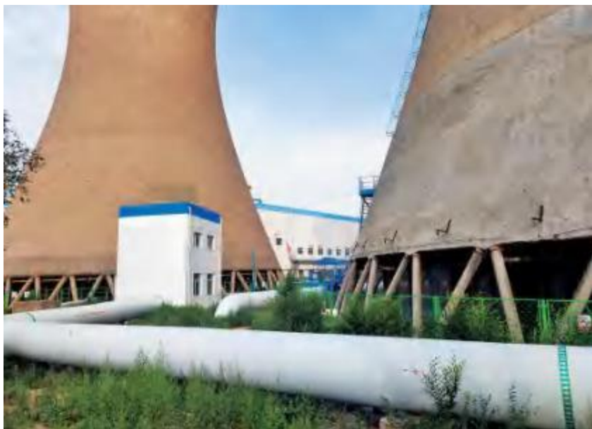
图54 2022年8月，包头二电厂完成20万千瓦机组循环水重构改造工程。图为改造后的4号冷却塔循环水泵房（包头二电厂供图）
