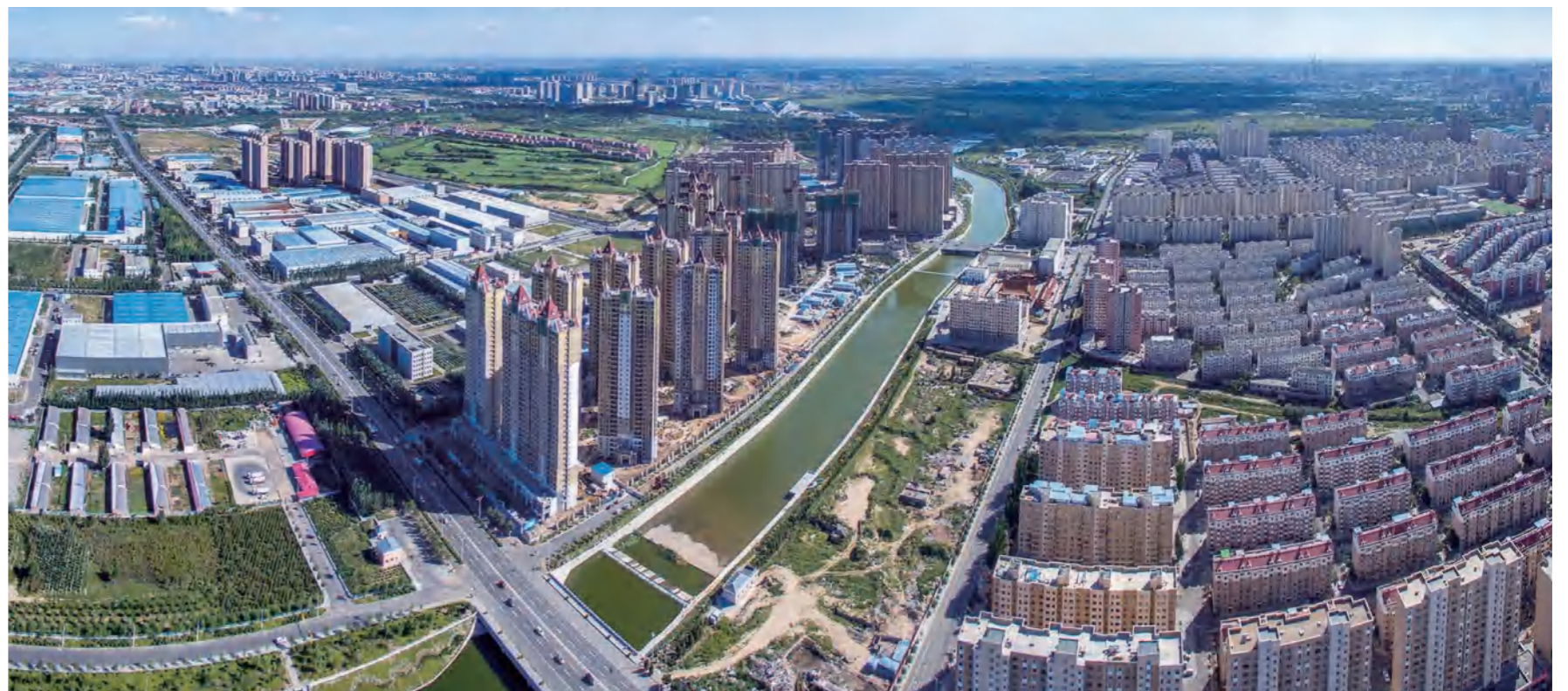
四道沙河生态治理工程
