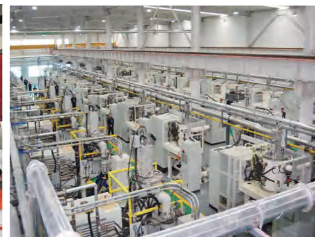
内蒙古京晶光电科技有限公司生产车间
