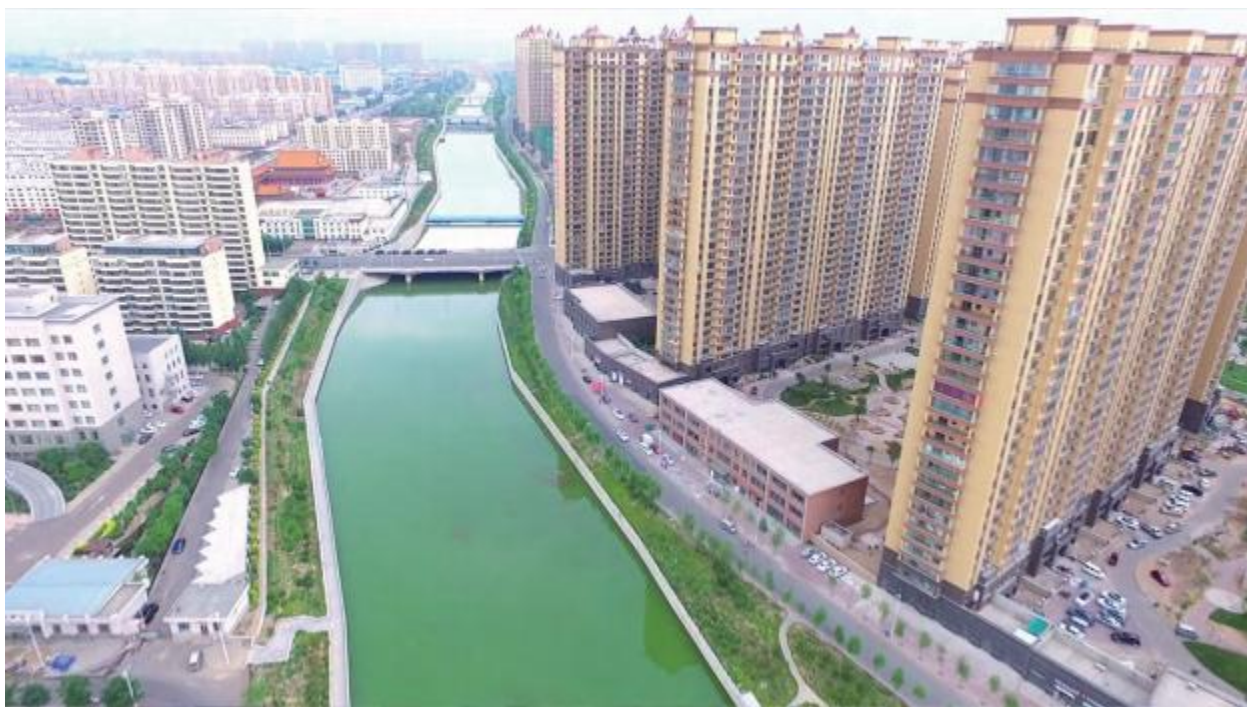
四道沙河生态治理工程
